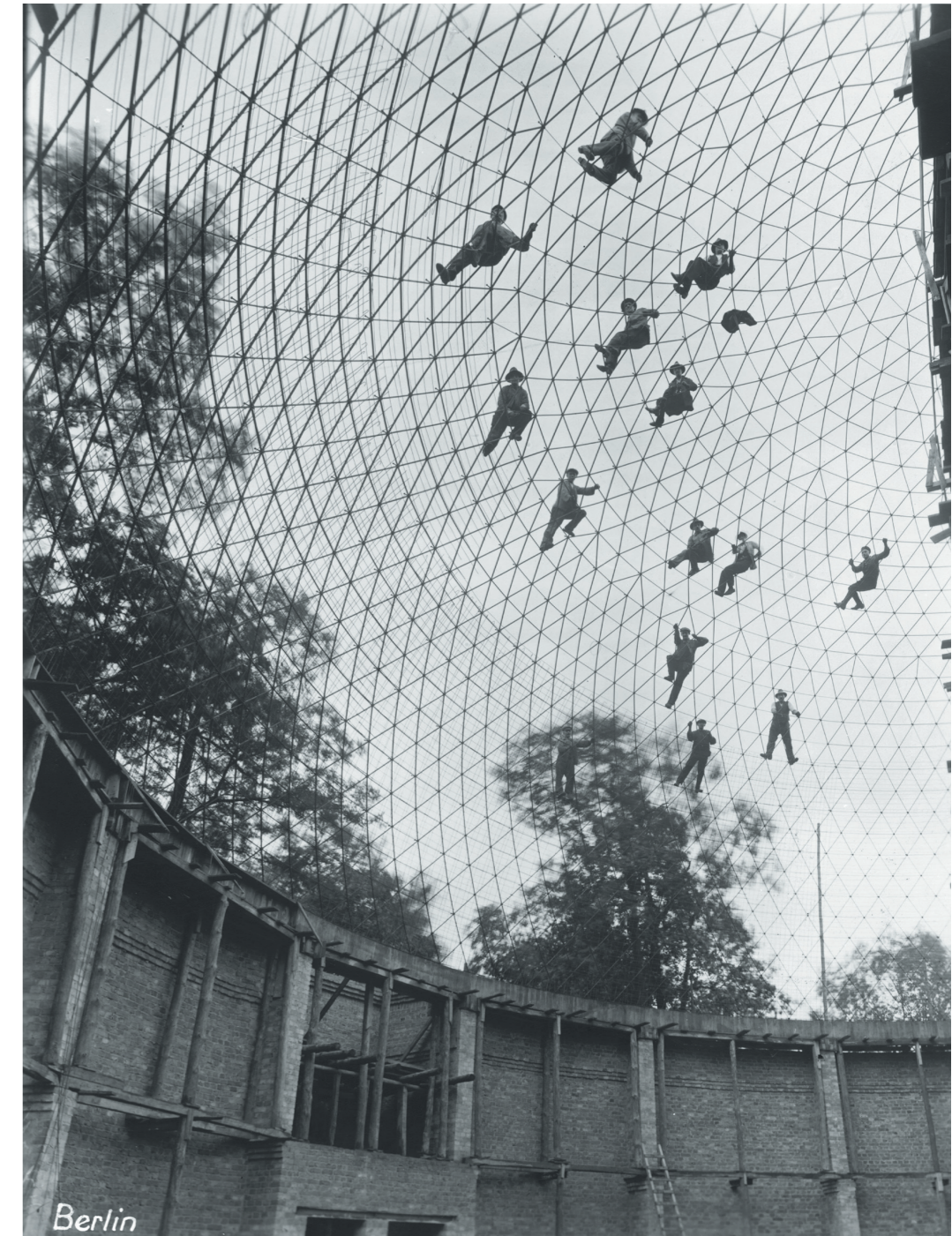
Planetarium Berlin Aufbau der Kuppel- konstruktion Carl Zeiss Archiv Jena
